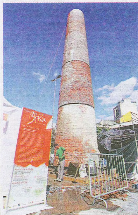
"A CORRENTEZA DE MODERNIZAÇÃO" – Em frente a Rodoviária, a casa sobre a chaminé, do japonês Tatzu Nishi
